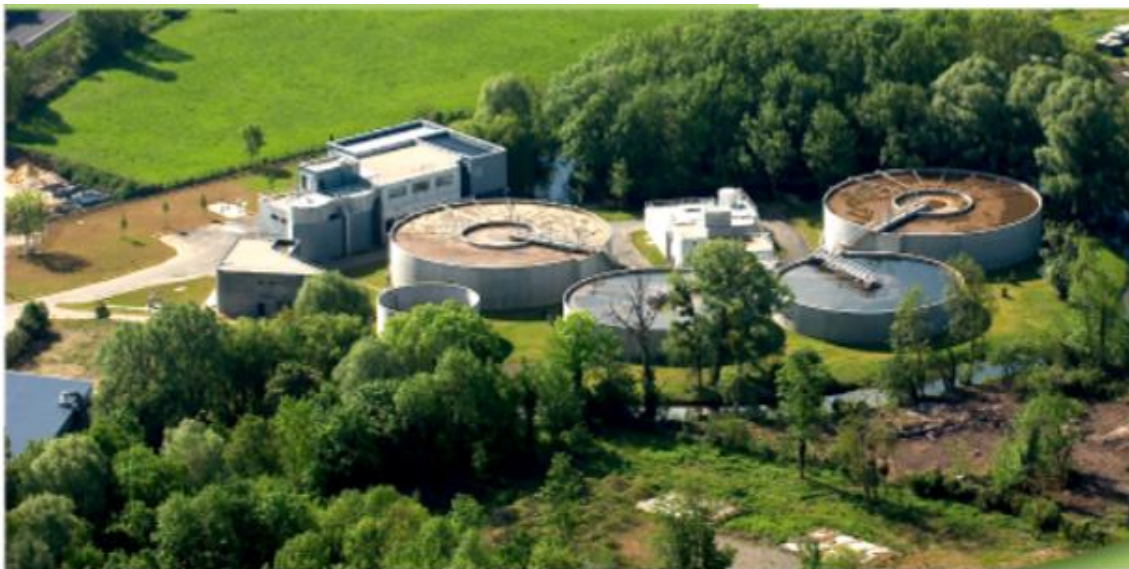
La station d'épuration d'Etampes
